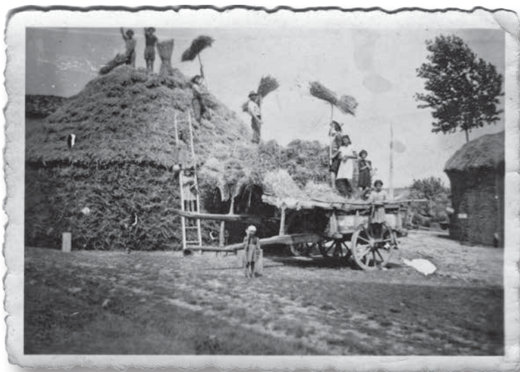
1948, Pedrolara. Costruzione del barco a casa Conti
